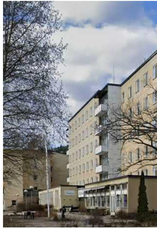
Befintlig puts karaktär och gestaltning.
